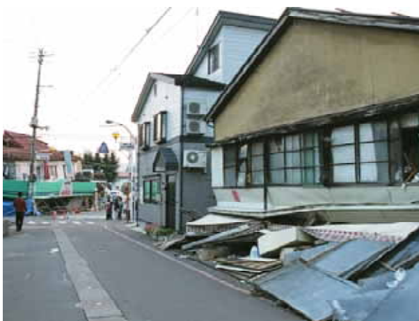
木造店舗の被害
