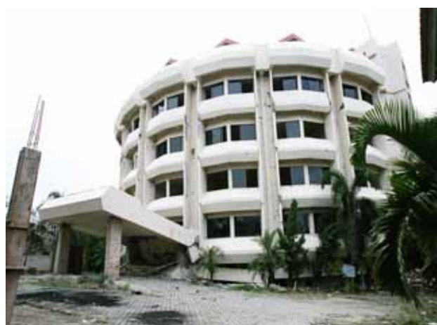
地震によるホテルの被害1
