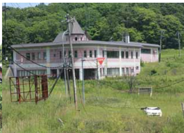
被災した建物 2
