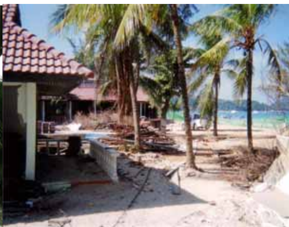
津波によるホテルの被害2
