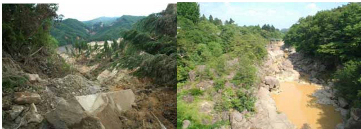
荒砥沢ダム周辺の地滑り
